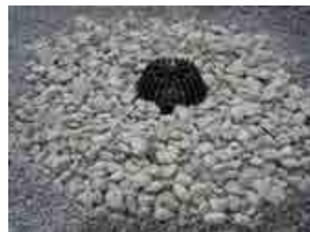
12. Ostatak površine ispuniti sljuncem
