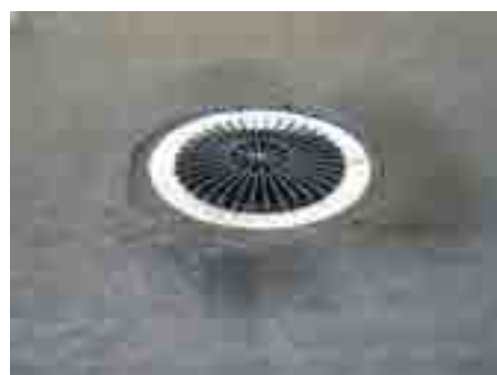
5. Stručno povezivanje slivnika u dvoslojnu bitumensku hidroizolaciju!
