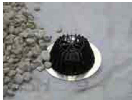
11. Postaviti hvatač lišća, i oko njega raspodeliti sljunak minimalne granulacije 16/32
