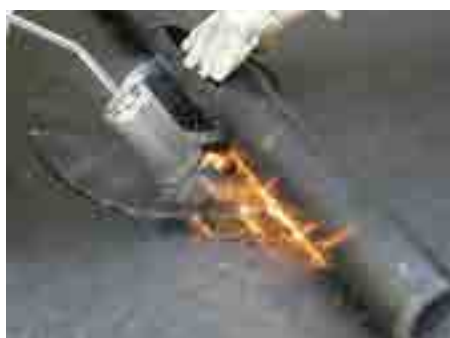
4. Zavariti drugi bitumenski sloj na kragnu slivnika
