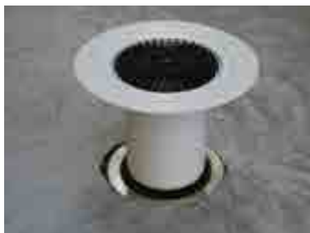
7. Postaviti nastavni element HL350.1 i drenažni prsten HL160
