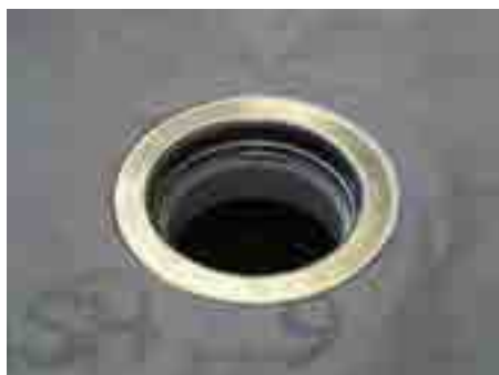
10. Na prirubnicu slivnika pričvrstiti geotekstil pomoću INOX prirubnice
