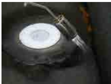
2. Zavariti bitumensku traku slivnika sa bitumenskom hidroizolacijom
