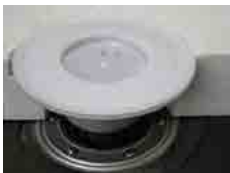
4. Nastavak sa priрубnicom (HL85N) podesiti na visinu toplotne izolacije, postaviti na drenažni prsten (HL180), postaviti privremenu građevinsku zaštitu
