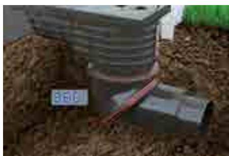
4. Podesiti pravac i nagib priključka
