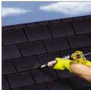
Krpljenje i popravku bitumenskih traka. Kao bitumenski lepak i zaptivač za mala i srednja preklapanja i reparacije sastava bitumenskih folija.
