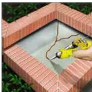
Za zaptivanje statičkih pukotina na betonskim pločama, pre aplikacije bitumenskog sloja. Za sva zaptivanja bez većih pritiskava vode.
