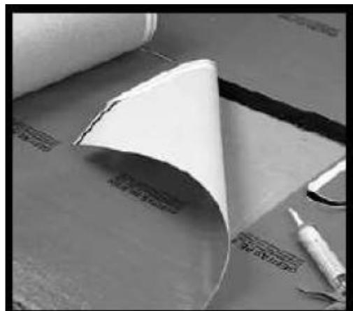
Sve vertikalne spojeve (krajeve i početak rolji) lepimo GEFITAS zaptivnom trakom ili lepkom iz kartuše
