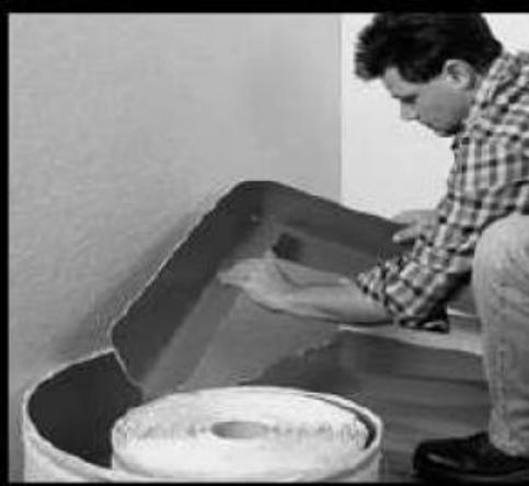
Spojevi za uglove posebno se poručuju ili izrađuju. Potrebno je voditi računa da ugradnja bude iznad predvidjene kote estriha.
