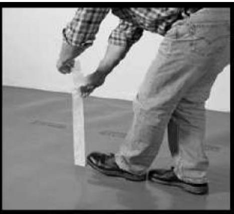
Zaštitnu traku ravnomernom brzinom uklanjamo, a spoj učvrstimo pritiskom noge
